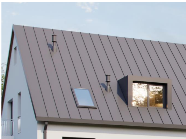
Dach – Falzmetall, Entwässerungssystem (Fallrohre, Regenrinne)
