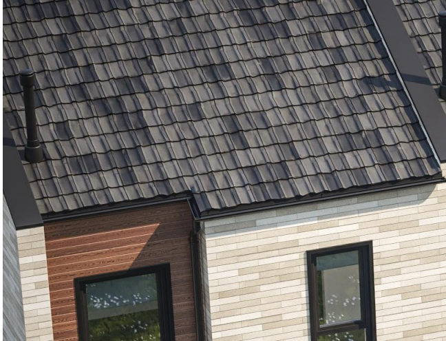
Ton Dachziegel, Entwässerungssystem (Fallrohre, Regenrinne)
