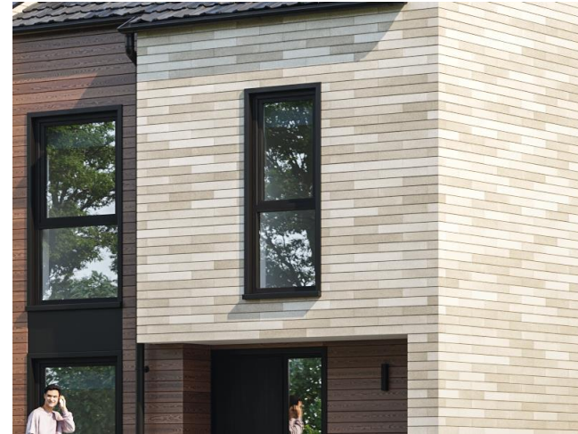
Fassade - Hinterlüftete Fassade Backstein Optik
