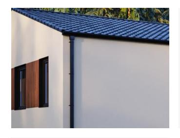
Ton Dachziegel, Entwässerungssystem (Fallrohre, Regenrinne)
