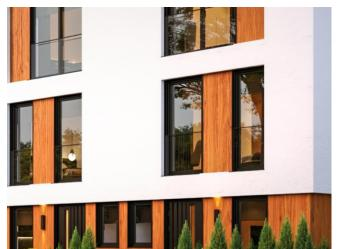
Beplankungsmaterial - Latten/ Lamellen Hinterlüftete Fassade
