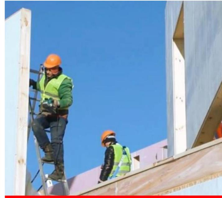
Basierend auf der Berechnung der statischen Lasten bildet KVH- Konstruktionsholz einen stabilen Rahmen des Gebäudes. Wände, Böden und Dach formieren OSB-Platten, sie fixieren den Gebäuderahmen. Zwischen den Konstruktionsholz und OSB in den Wänden, Decken und Dächern wird eine Dämmung angebracht, die für Wärme- und Schalldämmung sorgt. Für die Wasser- und Dampfisolierung sorgen spezielle Folien – Diffusionsmembranen.
